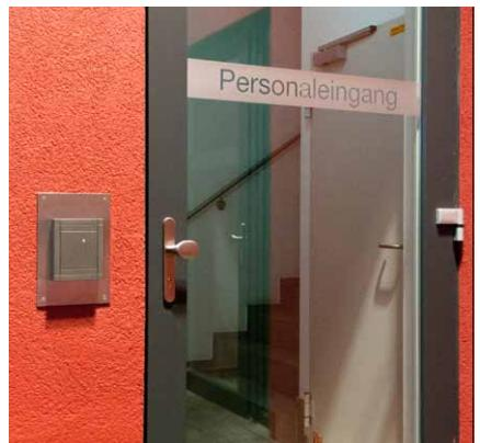
Der witterfeste RFID-Leser am Personaleingang lässt Mitarbeiter die Türen öffnen, ohne dass Schlüssel ausgegeben werden müssen. Scheidet ein Mitarbeiter aus, wird sein Zugang gesperrt.
